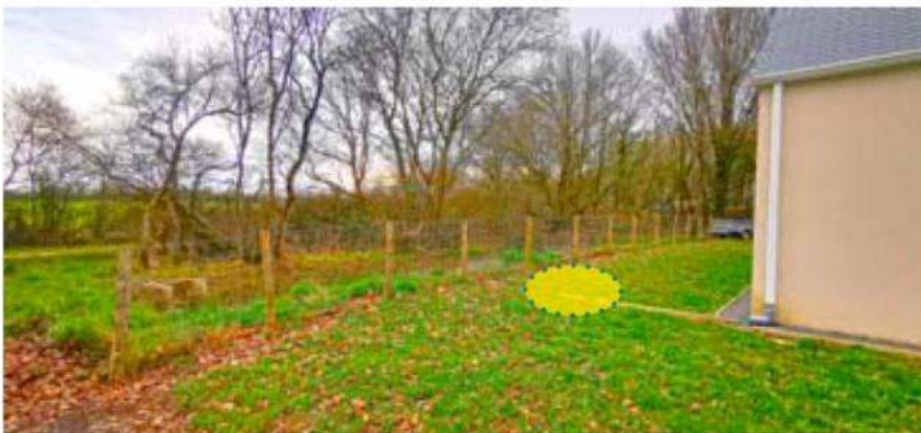
Caniveau CC1 aérien en pignon dirigé vers un bassin de rétention
