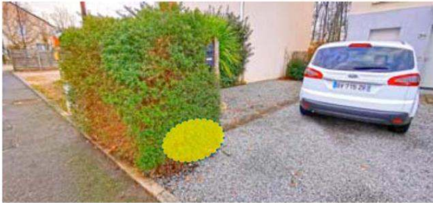
Caniveau CC1 aérien de la façade à la voie, traversant une haie
