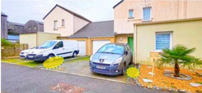
Caniveaux CC1 aériens de la façade à la voie, passant par l'aire de stationnement
