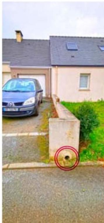
Canalisation à faible recouvrement avec traversée de muret de clôture sortant au-dessus du niveau de la voirie
