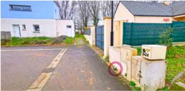
Canalisation à faible recouvrement avec traversée de muret de clôture sortant au-dessus du niveau de la voirie
