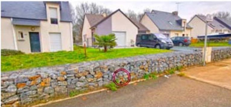
Canalisation à faible recouvrement avec traversée de muret en gabion sortant au-dessus du niveau de la voirie
