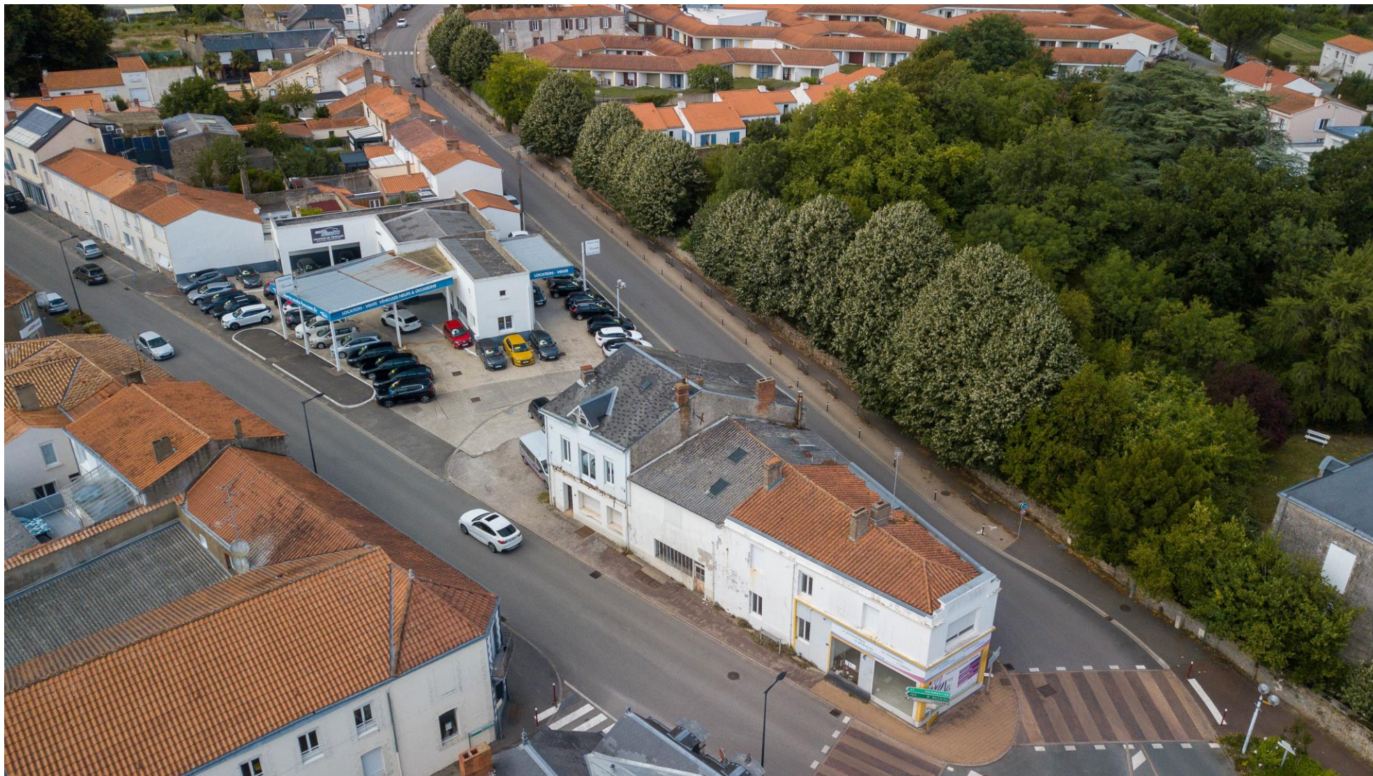
Lot 1 Soulard-Clemenceau (avant démolition)
