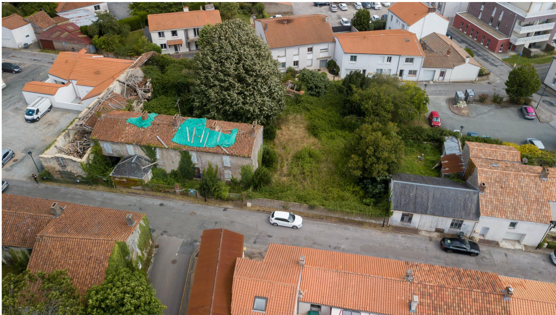
Lot 2 Rue Gobin (avant démolition)
