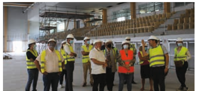
Visite de chantier Les travaux du futur complexe sportif se terminent prochainement.
