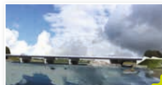
Chantier 2x2 voies construction d'un viaduc
