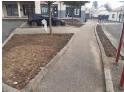
Actuellement - Exemple de massif Place de la Mutualité - Terrain préparé pour les futures plantations
