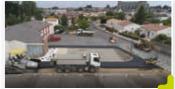
Aménagement du parking des pompiers
